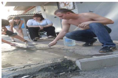
Рис.1.-Строительство пандуса отрядом «Горящие сердца» [2]
